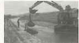
図7 生息環境改善のための「袋詰め玉石」設置
